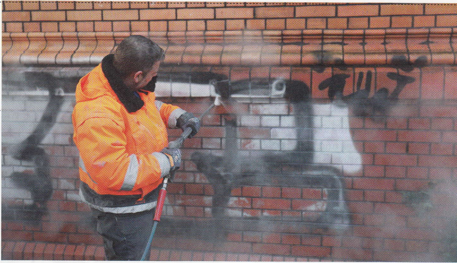
Entfernung einer Graffitiattacke im Berliner Stadtteil Kreuzberg
